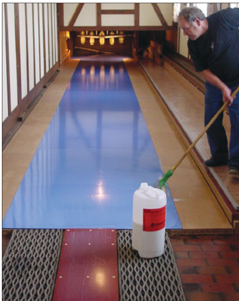
Die Versuchsanlage mit Laminatbelag. Die Bahnen werden gleich behandelt wie die normalen Bahnen. Bild: www.engel-hueswil.ch
